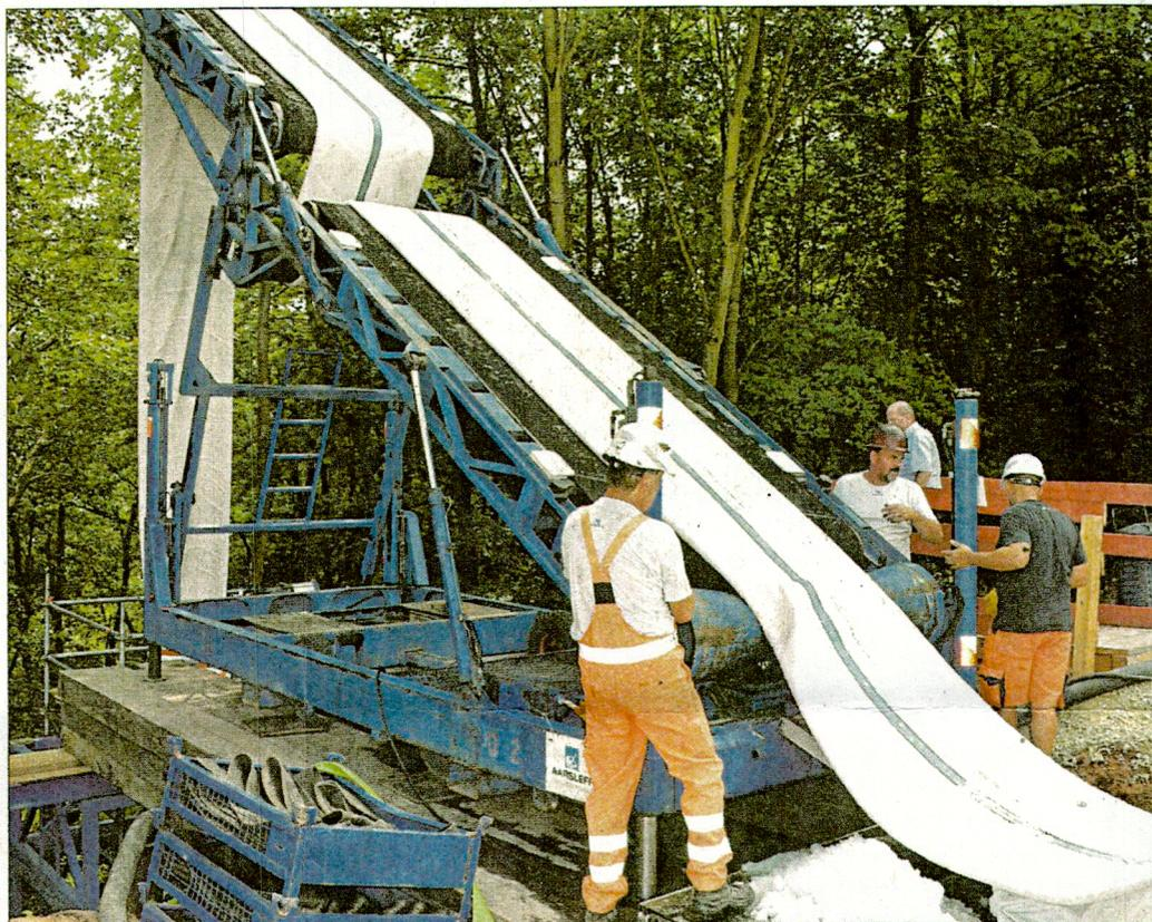
Über ein Förderband wird der Kunststoffschlauch, der sogenannte Liner, in den Kanalschacht hineingelassen. Dort dehnt er sich mit Wasserdruck aus – und kann dann quasi ein neues Rohr im alten bilden.
