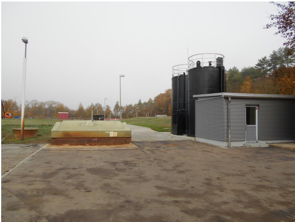
Blick auf das neue Dosiergebäude mit den beiden neuen Lagertanks à 30 cbm; Ausführung nach Wasserhaushaltsgesetz.
