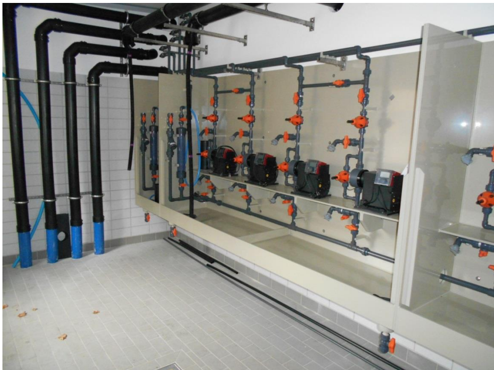
Montage der Dosierpumpen im Dosiergebäude
