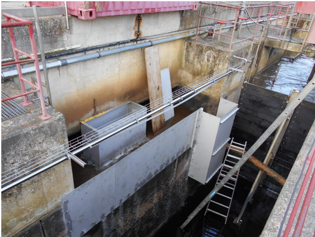
Eine der sechs neuen Dosierstellen wird montiert (alles im laufenden Betrieb der Kläranlage)
