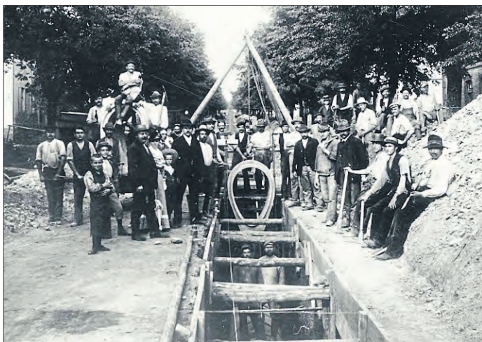
Anfang des 20. Jahrhunderts begann der systematische Ausbau der Abwasserentsorgung (hier eine Kanal-Baustelle 1903, vermutlich in Bahnhofsnähe). Foto: Stadtarchiv Fulda
