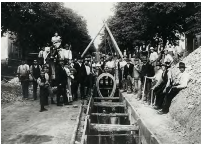
Anfang des 20. Jahrhunderts begann der systematische Ausbau der Abwasserentsorgung (hier eine Kanal-Baustelle 1903). Foto: Stadtarchiv Fulda
