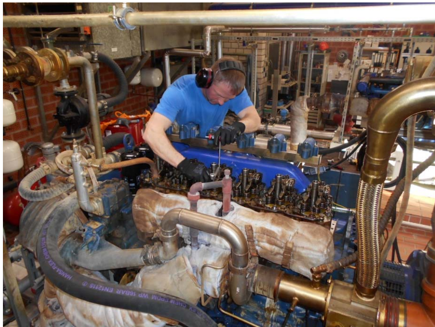
Wartungsarbeiten am BHKW durch eigenes Fachpersonal
