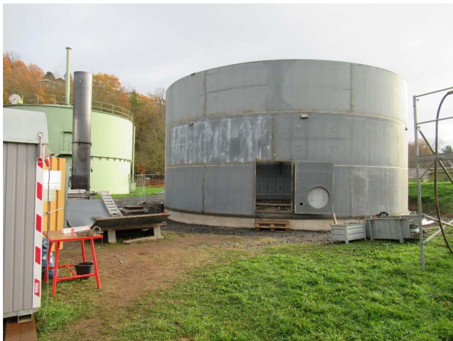
aktueller Stand zur Montage des Gasbehälters (Stahlbau)
