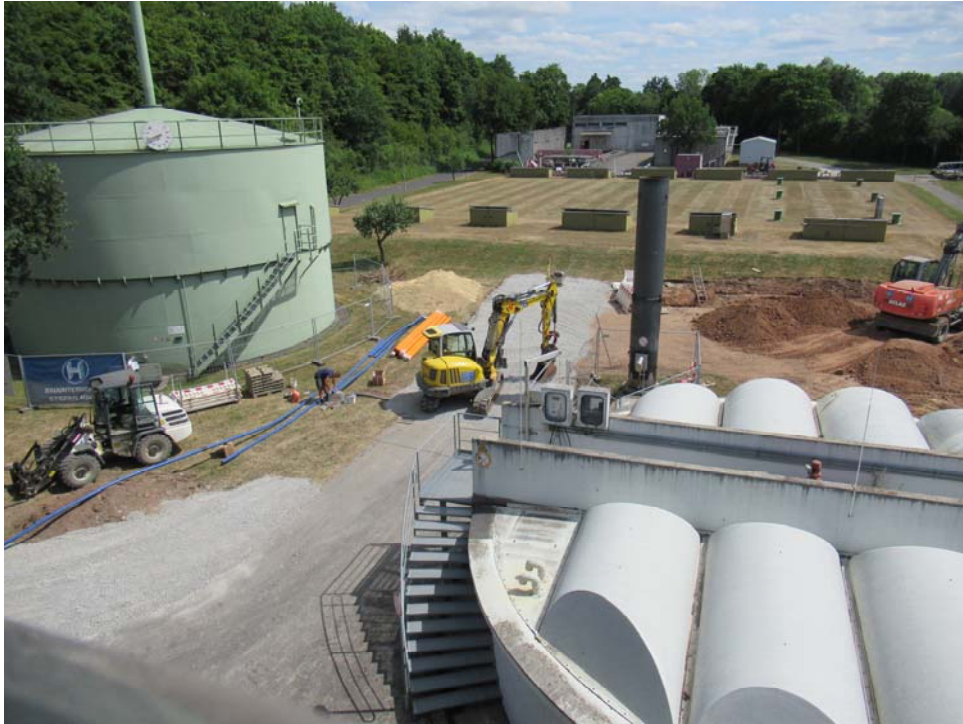
Erd- und Gründungsarbeiten sowie Umlegung von Rohrleitungen
