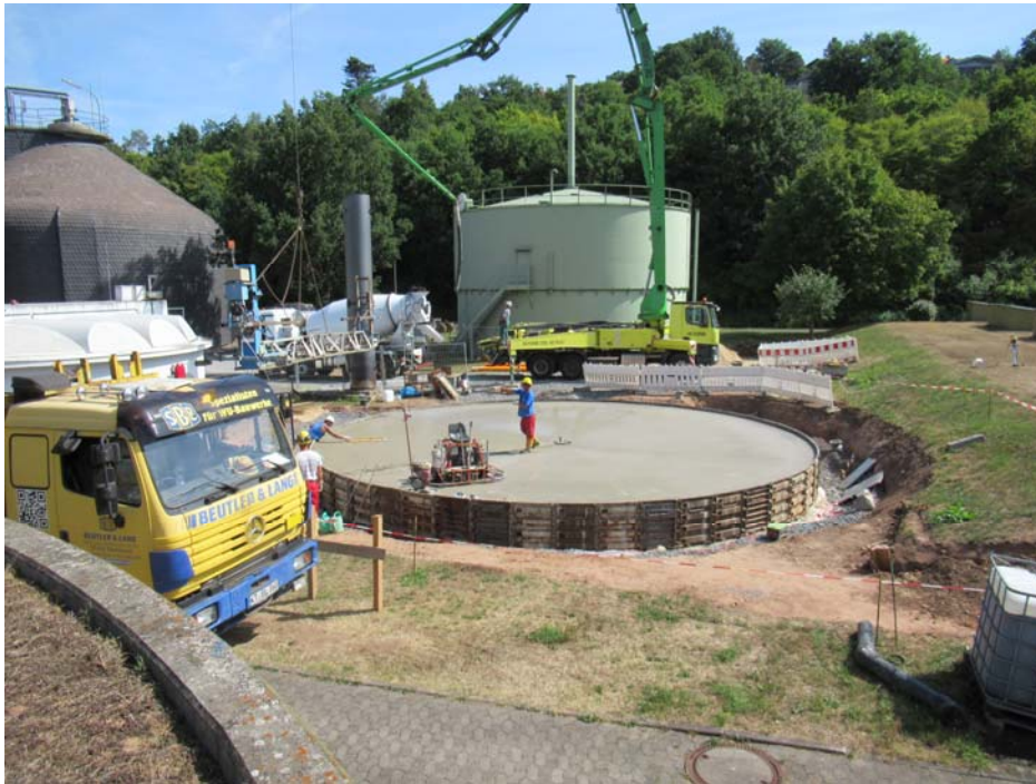
Betonarbeiten Bodenplatte
