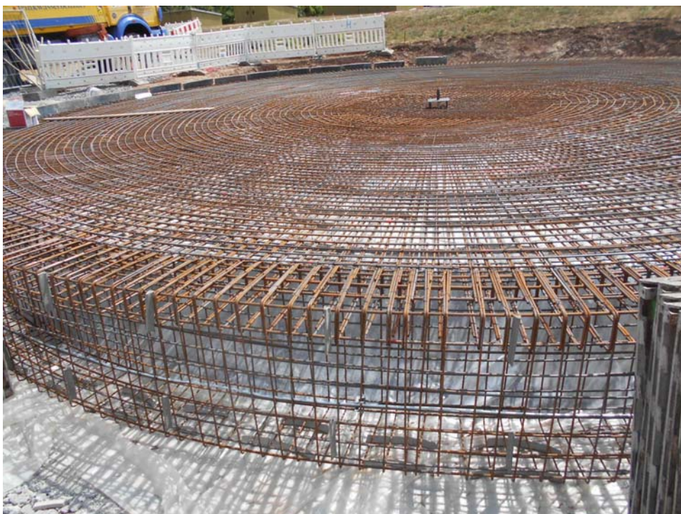
Stahlbewehrung für Bodenplatte Gasbehälter
