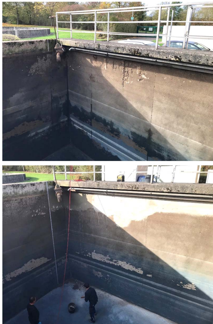
Bsp. partielle Betonsanierung - Eindicker, Kläranlage Fulda-West
