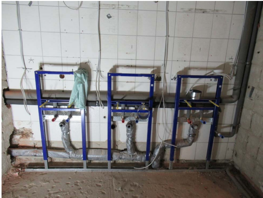
Blick auf die Vorwandinstallation für den neuen Waschbereich
