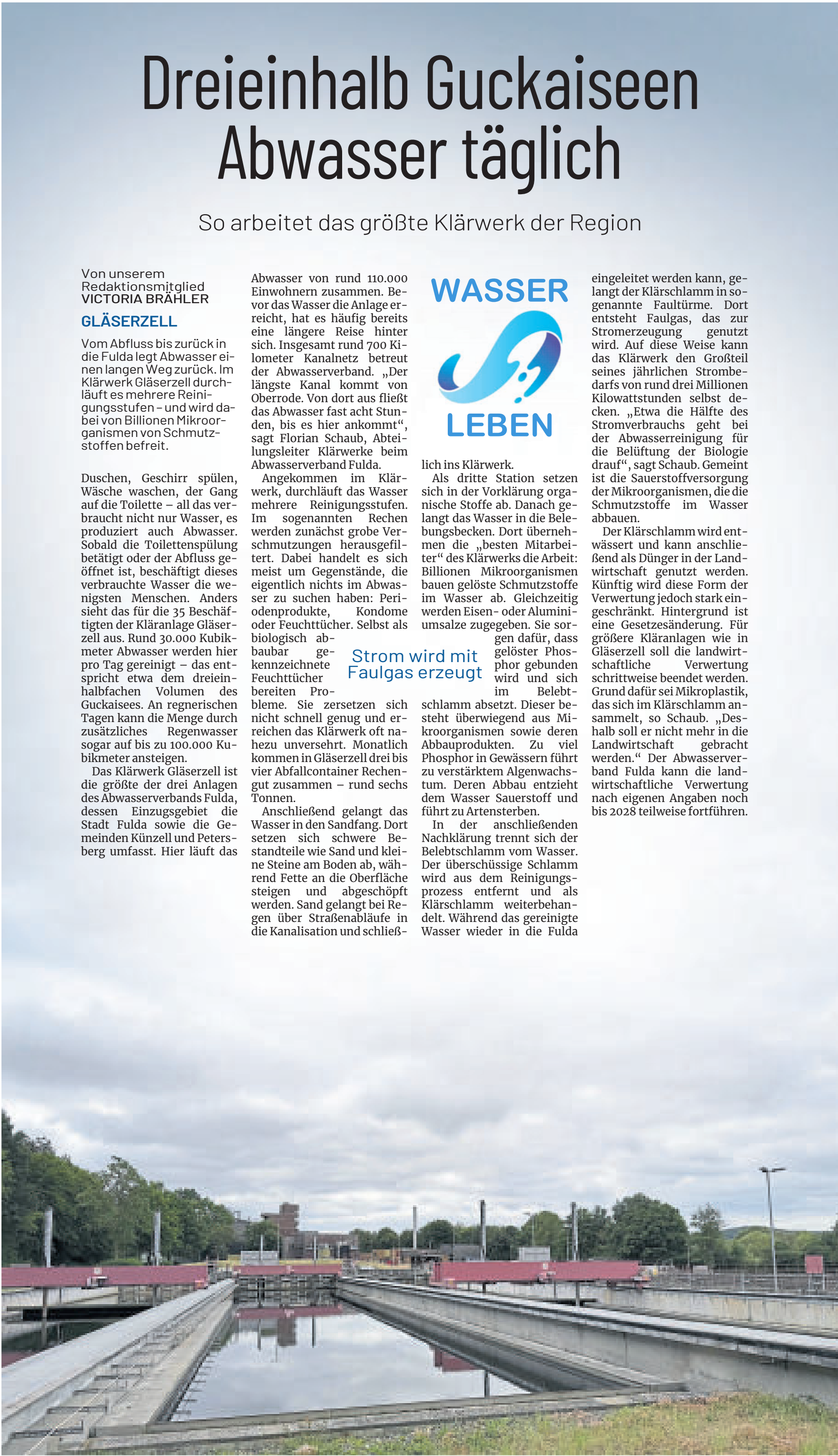
In den Nachklärbecken wird das gereinigte Abwasser vom Belebtschlamm getrennt – einer Ansammlung von Mikroorganismen, die organische Stoffe abbauen. Foto: Victoria Brähler
