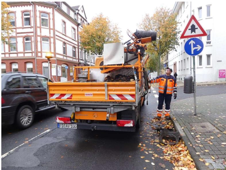
*Reinigung der Sinkkästen mit Hilfe einer Hebeeinrichtung für die Sinkkästeneimer (Heinrichstraße) mit einem Spezialfahrzeug des Abwasserverbandes*
